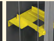
レールブラケット補強対策
